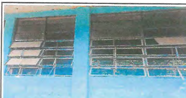
Foto 6: Vidrios de ventanas destruidos.
